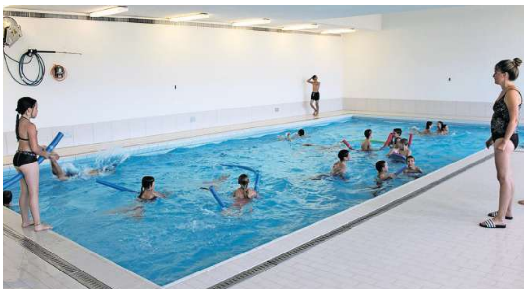
Das Lernschwimmbecken in der Sproochbrugg ist in die Jahre gekommen. Es soll ab Sommer 2021 saniert werden. Bild: Ernst Inauen
