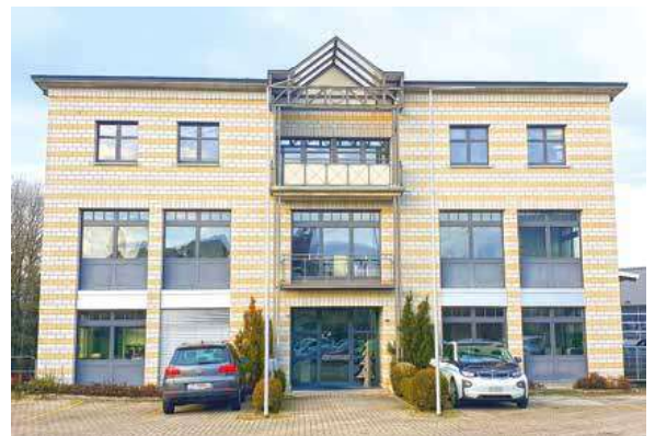
Das Firmengebäude an der Kieswerkstrasse 4 in Aadorf.
